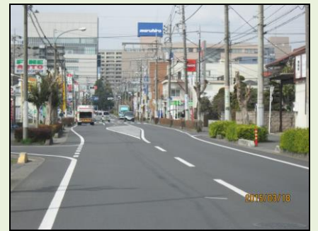
東飯能駅東口通りの舗装打ち換え
