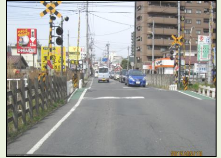
柳原地区の踏切拡幅完成間近
